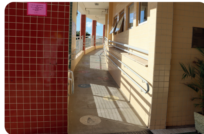
Rampa de acesso
